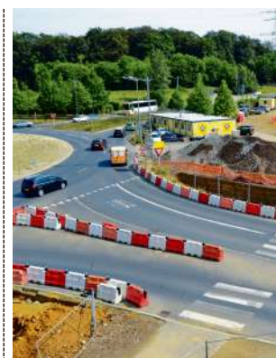
Des travaux sont déjà en cours près du rond-point Serra.
